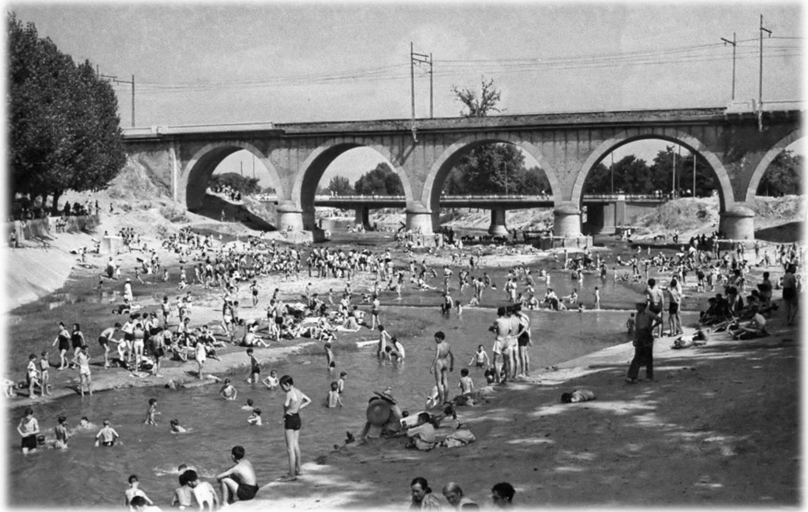
Río Manzanares junto al Puente de los franceses. 1956.
